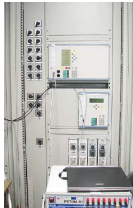
Рис. 8 (справа). Шкаф, содержащий терминал автоматики управления Siemens 6MD664 (АПВ, УРОВ, ФОЛ, ФОВ), и терминал основных защит ВЛ 500 кВ. Основные защиты ВЛ 500 кВ выполнены в корпусе шириной 1/2 от стандартной ширины корпуса 19 дюймов, что стало возможно благодаря использованию GOOSE-сообщений.
