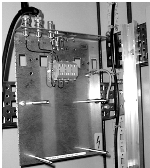
Рис. 7-9 Плата A9CS для подключения ВЧ-кабелей
