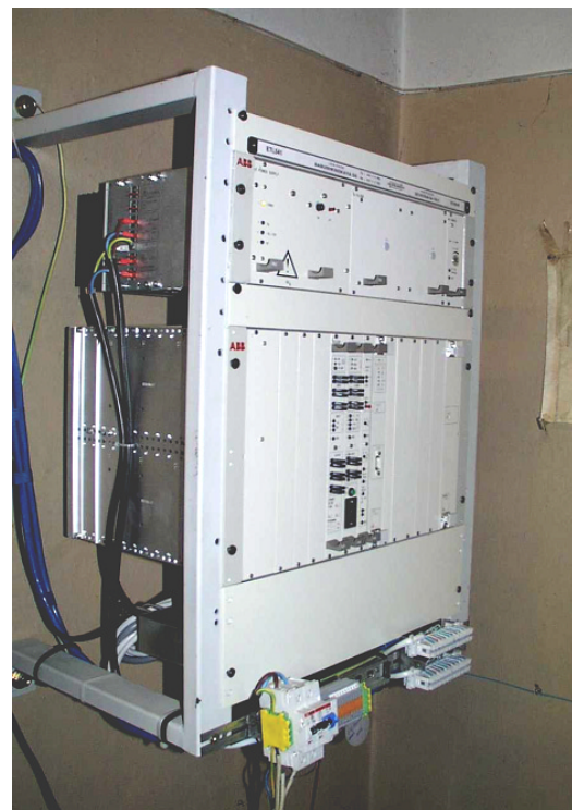
Рис. 7-5 Внешний вид аппаратуры ETL541 размещенной в открытом фрейме (настенная установка)
